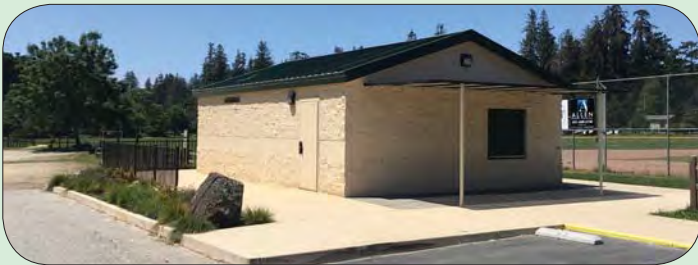
Edificio de Baños y Concesión en Polo Grounds County Park en Aptos
